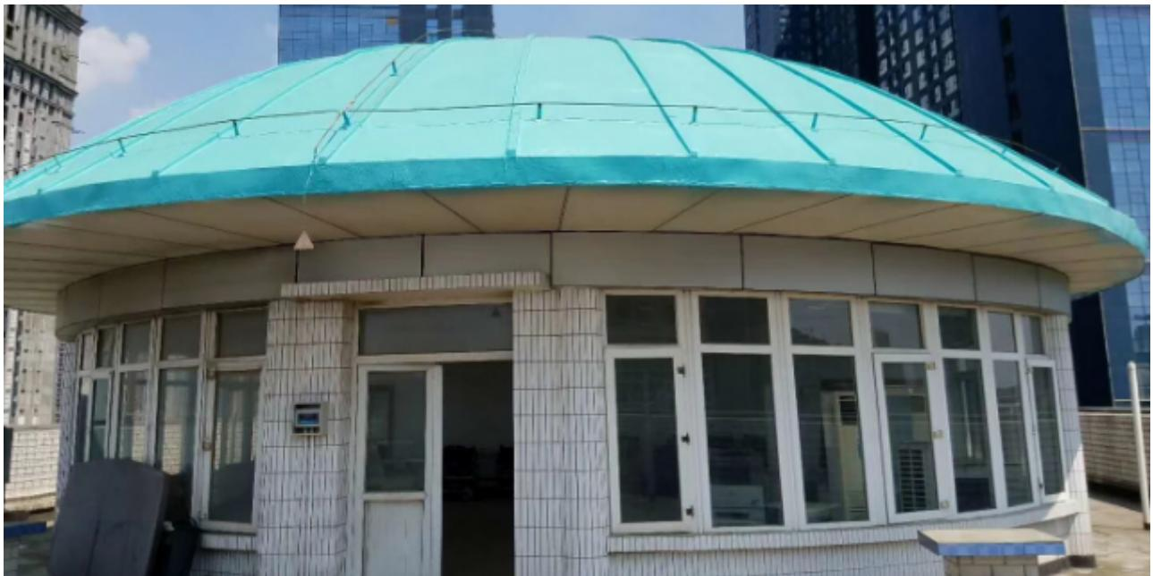
聚脲防腐底涂组成由渗透型专门用于树脂、聚氨酯改性环氧树脂、成膜助剂、固化剂等组成的双组份常温固化漆。主要特性渗透性强，封闭性能优异，可提高基底强度；对基底具有优异的附着力；与Spua系列产品具有良好的配套性；涂层耐碱、耐酸、耐水性能优异；可刷涂、滚涂，施工性能优。用途用于混凝土、木材、水磨石、钢铁等基材表面作封闭底漆，避免后续涂层出现鼓泡和孔现象。成由端羟基化合物与异氰酸酯反应制得半预聚及端氨基聚醚、催化剂、颜料、助剂等现场施工防腐涂料。主要特性固化快，施工不流挂，可一次施工达要求，施工周期短；涂层致密、连续、光顺、无接缝；固体含量100%，无味、无毒、无污染，符合环保要求；对湿度和温度不敏感，不发泡，施工不受环境条件的影响；具有优异的物理性能；耐紫外线老化，在户外长期使用不粉化、不开裂；耐介质性能突出，可耐受水、盐、酸、碱、油等介质的侵蚀；对钢、铸铁、铝等底材均具有优良的附着力，长期使用不脱落、不空鼓。
