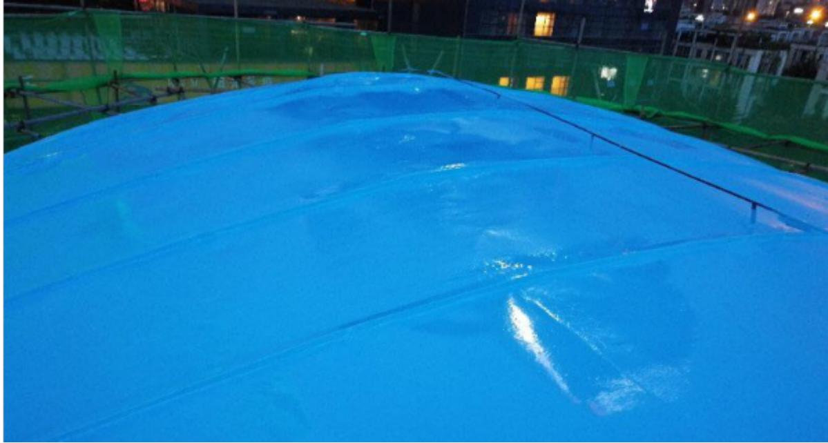
聚脲防水涂料 [Spray Polyurethane Waterproofing Coating] 是引进国外先进技术，结合国内重点项目建设工艺要求研发的一种无溶剂、无污染、高反应型防护涂料。产品说明：适用于国家重点工程项目建筑物之所有混凝土表面、金属罐体和管道内外表面“两防一耐”（防水、防腐、耐磨）分项工程，已广泛应用于城市地铁、高速铁路、隧道桥梁、水利机电、石油化工、海洋钻探、军民两用等工程领域。聚脲树脂是含有异氰酸基-NCO的单体或预聚物与含有氨基-NH<sub>2</sub>-NHR的单体或预聚物经加成缩合反应得到的聚合物树脂。天冬聚脲属于聚脲的一类，属于第三代聚脲聚脲材料经过多年发展，目前发展出了芳香族喷涂聚脲（超前代）、脂肪族喷涂聚脲（第二代）、聚天门冬氨酸酯聚脲（第三代）。山东德士力新材料科技有限公司在客户和行业中树立了良好的企业形象。聚氨酯喷涂聚脲喷涂视频
